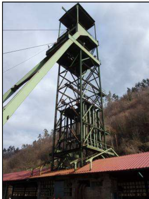
Fotografía 6-8- Vista del Pozo Samuño
