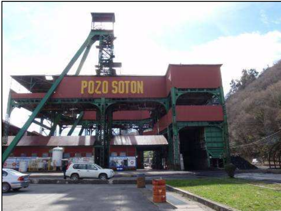
Fotografía 6-3.- Vista del Pozo Sotón
