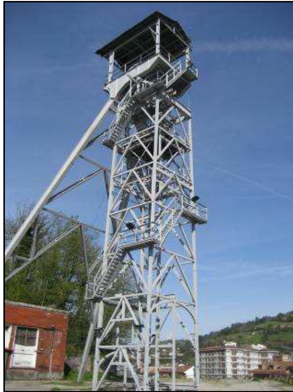
Fotografía 6-6.- Vista del Pozo Entrego
