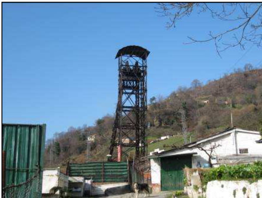
Fotografía 6-8-- Vista del Pozo San Vicente
