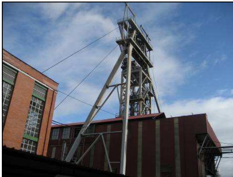
Fotografía 6-4.- Vista del Pozo María Luisa
